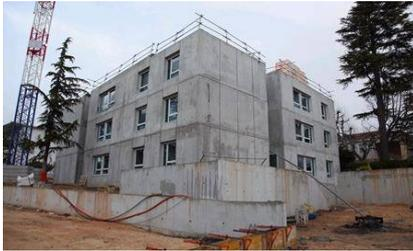
Structure constituée d'éléments masqués en béton.
